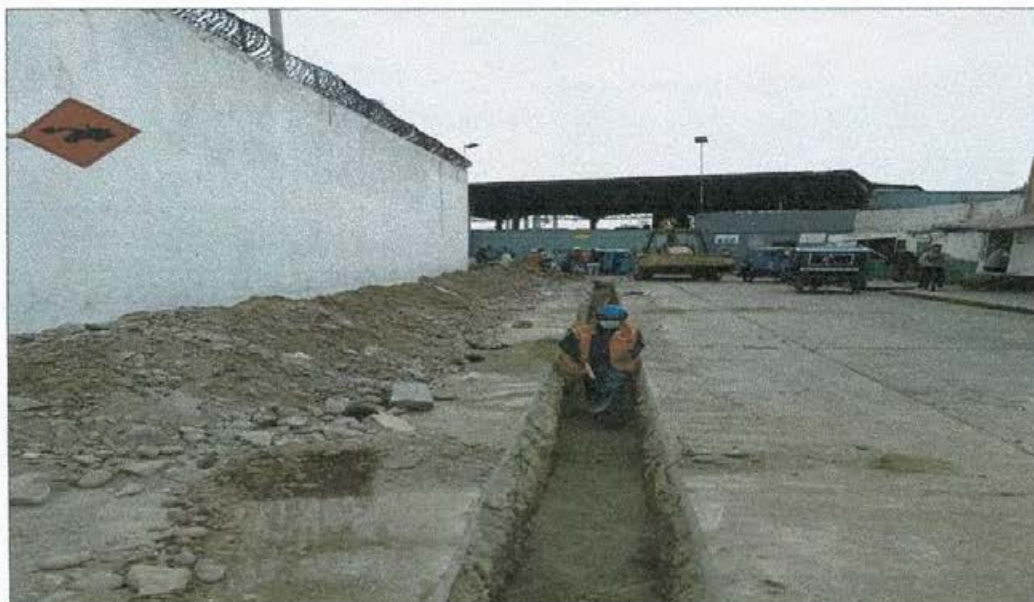
EXCAVACION DE LINEA DE IMPULSION - IMAGEN 02
