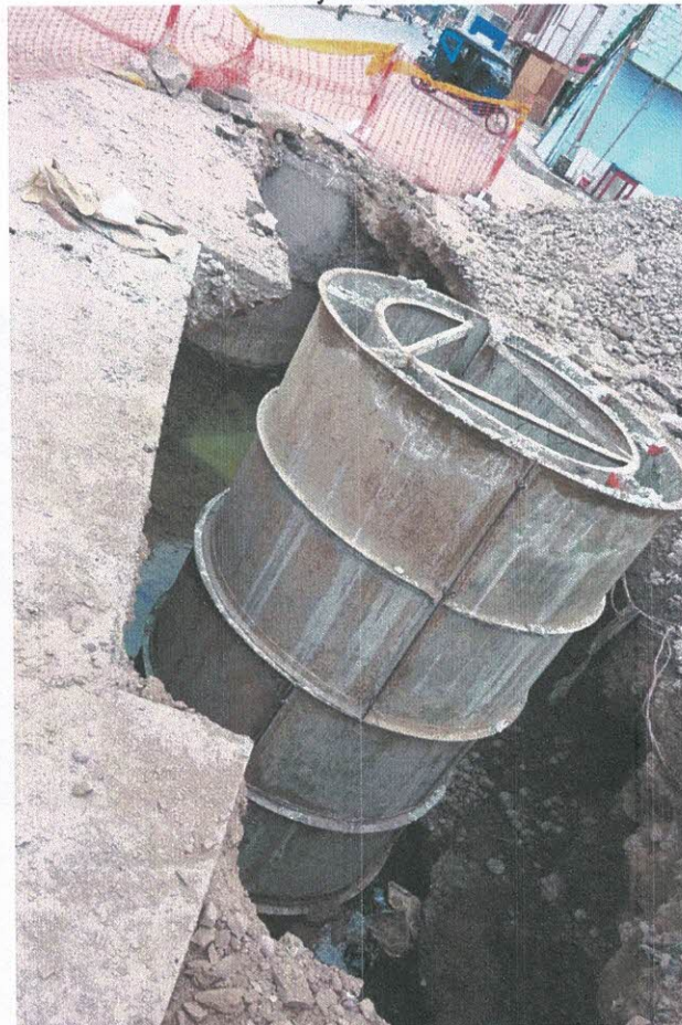
Proceso de encofrado de buzones
