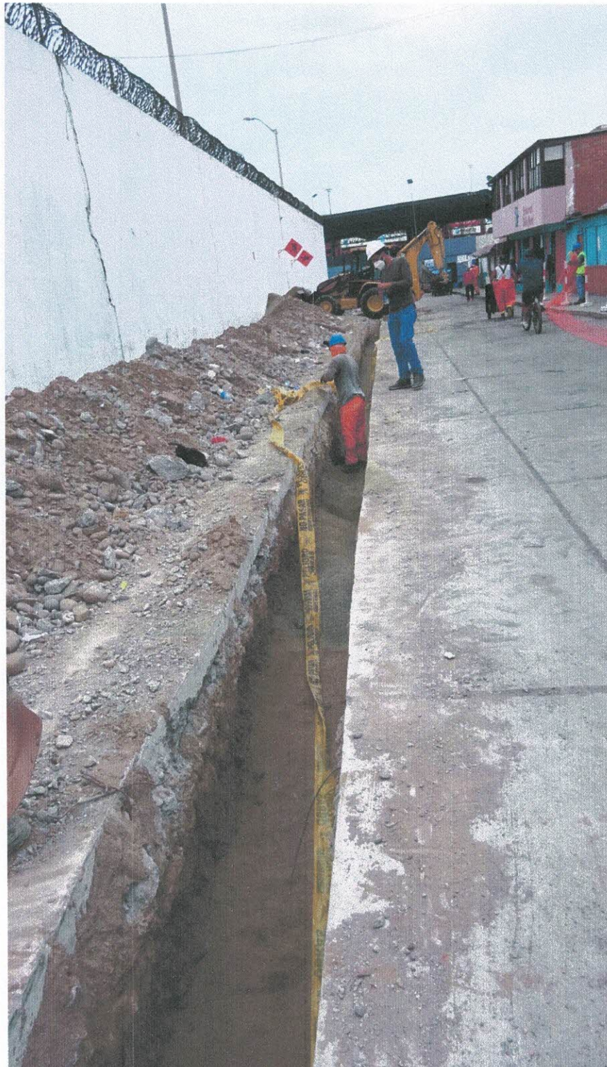
Proceso de excavación y de colocación de cama de arena
